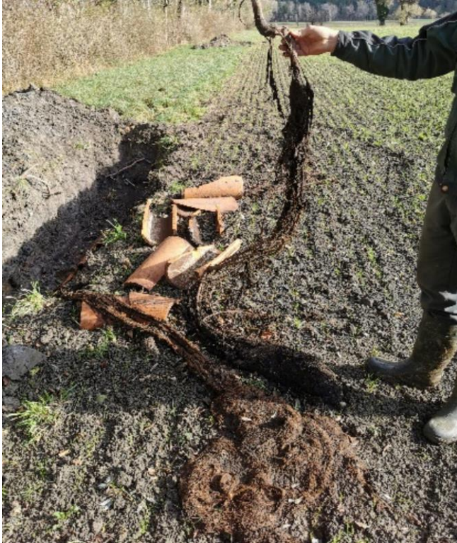
Beschädigte Drainagerohre durch fehlende Windschutzpflege
